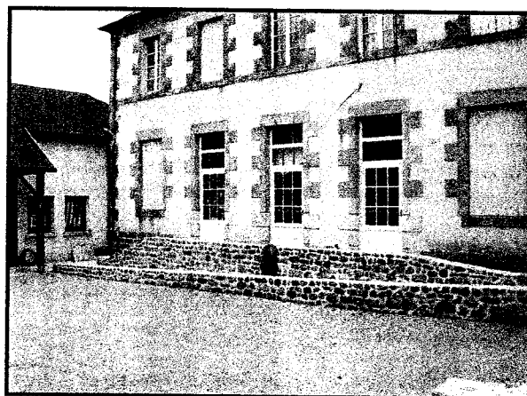
L'arrière de l'école après travaux
